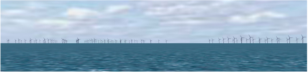
Kaikki voimalaryhmät Lohikarin suunnasta katsottaessa. Osa voimaloista ei näy kuvassa.
