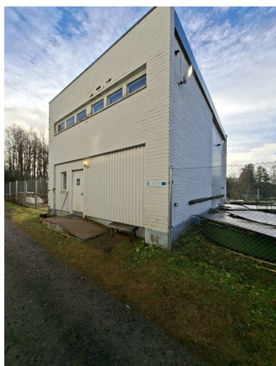
Piha: Yleiskuva rakennuksen julkisivusta etupuolelta päin kuvattuna.
