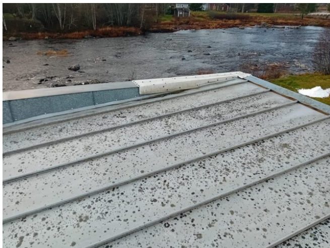
Vesikatto: Yleiskuva rakennuksen katolta.
