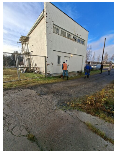
Piha: Yleiskuva rakennuksen julkisivusta etupuolelta päin kuvattuna.
