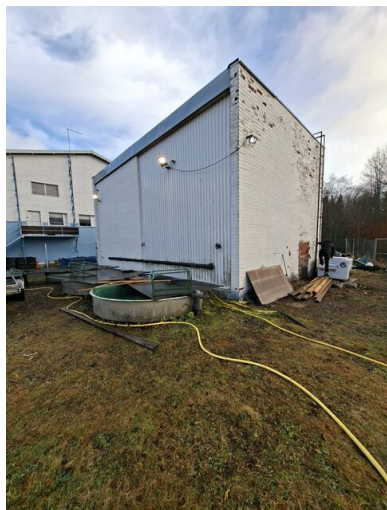
Piha: Yleiskuva rakennuksen julkisivusta etupuolelta päin kuvattuna.
