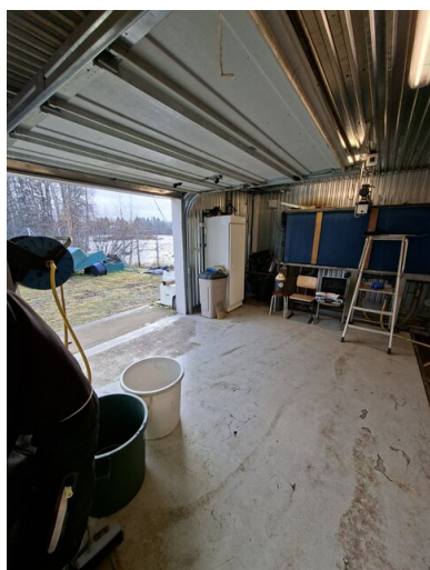
Kalahautomo: Yleiskuva nosto-ovelle päin kuvattuna.
