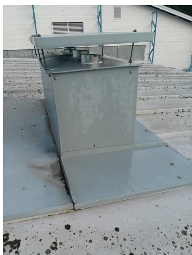
Vesikatto: Yleiskuva rakennuksen katolta.
