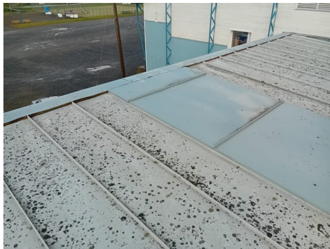
Vesikatto: Yleiskuva rakennuksen katolta.
