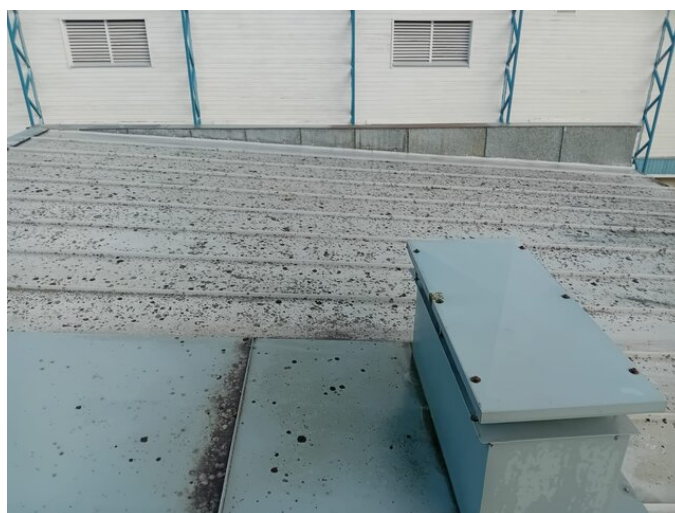
Vesikatto: Yleiskuva rakennuksen katolta.
