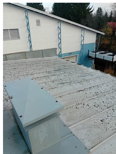
Vesikatto: Yleiskuva rakennuksen katolta.
